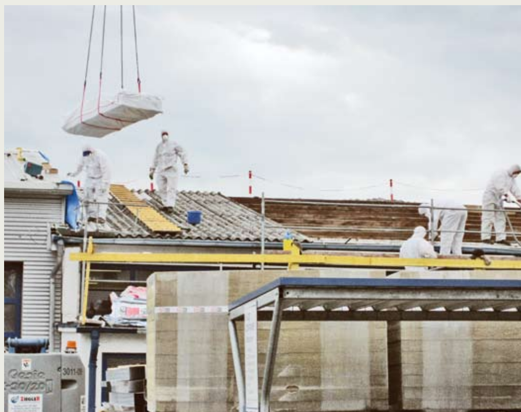
Overalls, Big-Packs, Atemschutz, Bindemittel und Personenschleusen – das Dachdeckerteam demontierte 2.600 m 2 Wellplatten.
