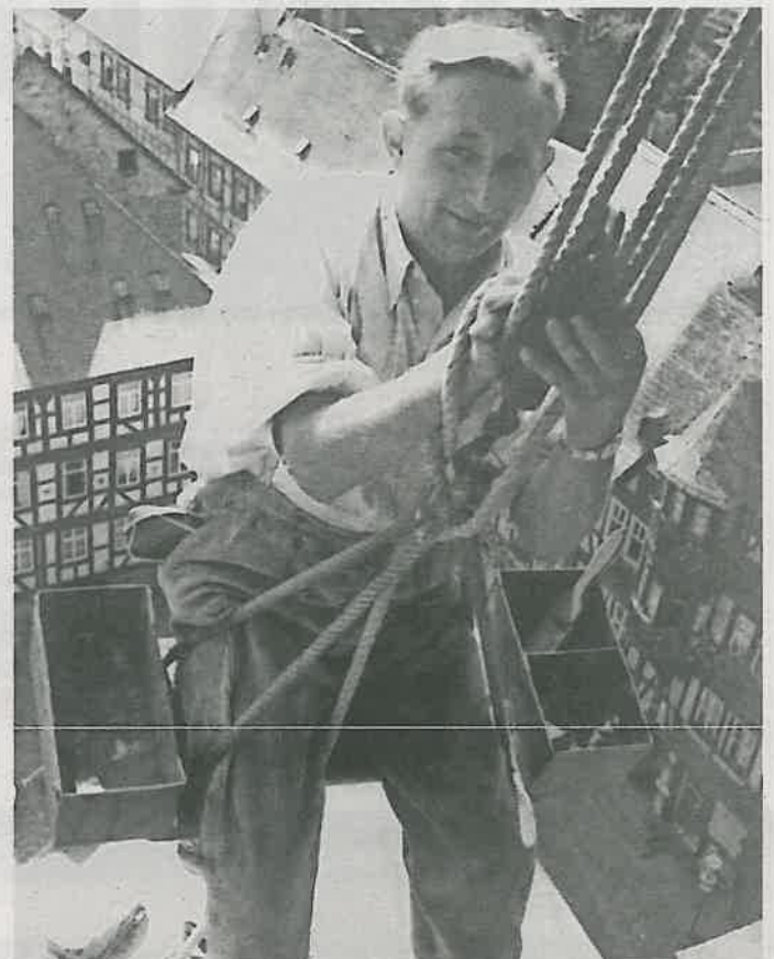
1961 in den Seilen an den Türmen der Pfarrkirche St. Jakobus: Der junge Dachdeckermeister Klemens Ott hatte sich gerade ein Jahr zuvor selbstständig gemacht.
