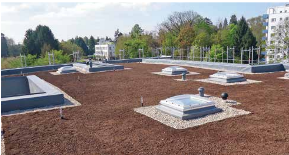
3.600 m 2 Dachfläche wurden mit einer wurzelfesten Sarnafil-Kunststoffdachbahn abgedichtet.
